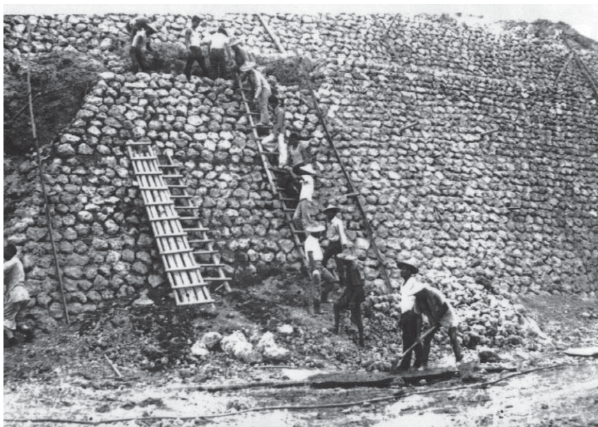
照片 44 大殿興建·接力賽——擋土牆
