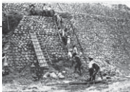
照片 44 大殿興建，接力賽——擋土牆
